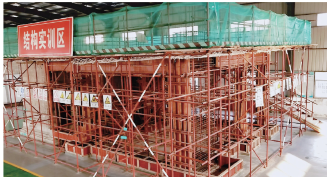
建工实训中心结构实训区主体部分，结合现代BIM信息化手段，按照建筑工地真实施工作业场景1:1打造，满足施工技术课程教学实训要求
